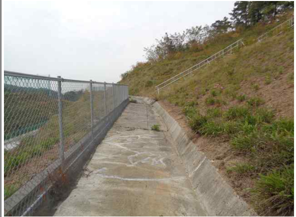
1소단 배수로 전경
