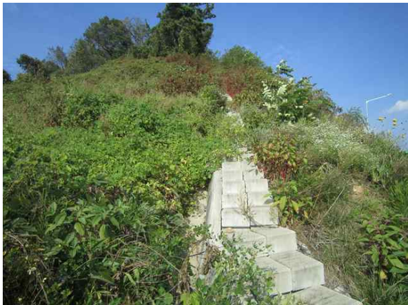
콘크리트 점검계단 전경
