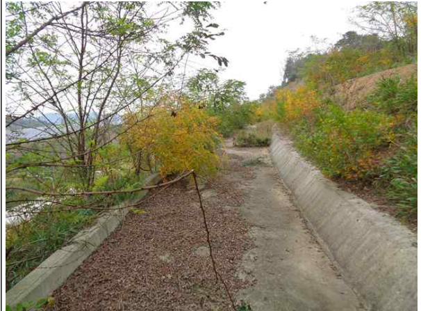
1소단 배수로 전경
