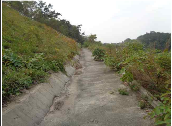
1소단 배수로 전경
