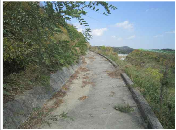
1소단 배수로 전경
