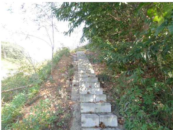
콘크리트 점검계단 전경
