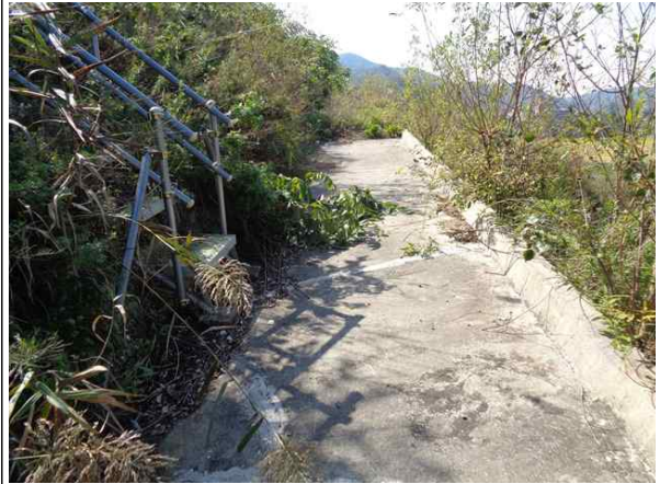
1소단 배수로 전경
