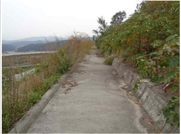
1소단 배수로 전경
